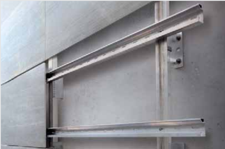
Dettaglio della struttura a scomparsa Wallfix S1
